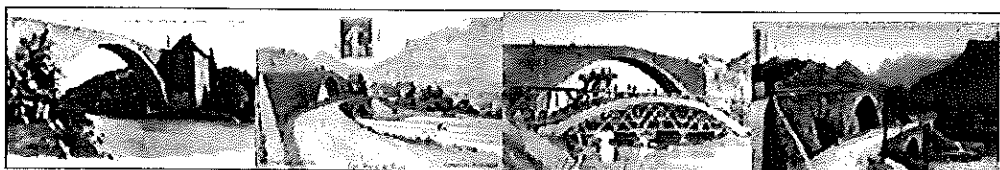
Le pont de Claix
